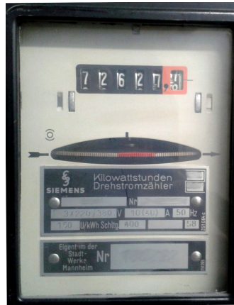
Abbildung 2.1.: Ferrariszähler (Schwöbel, 2015)
